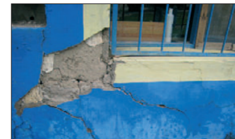
Det gamla huset som är byggt av lertegel är svårt skadat och olämpligt att använda som bostad.
